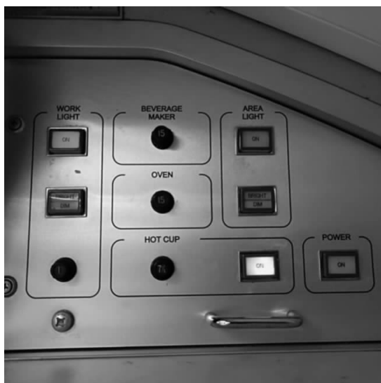
图 3-7 厨房电源控制面板
